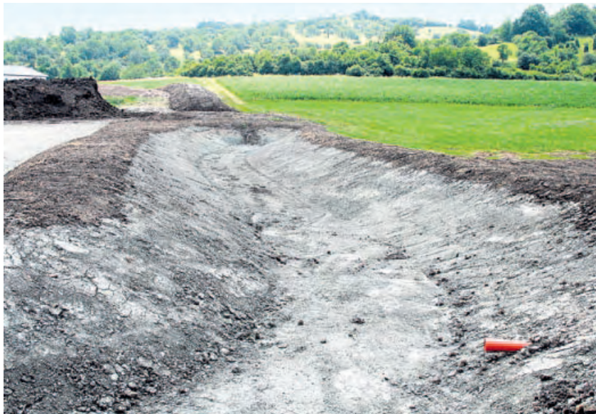
Über das neue Regenrückhaltebecken soll das Oberflächenwasser im Westen der Industriestraße geregelt abgeleitet werden. Foto: Hildenstein
